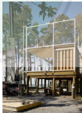
**Gambar 2.25.** Proses pemasangan bahan fabrikasi pada kerangka bangunan
