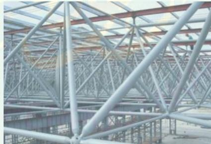
**Gambar 2.49** struktur *Space Frame*
