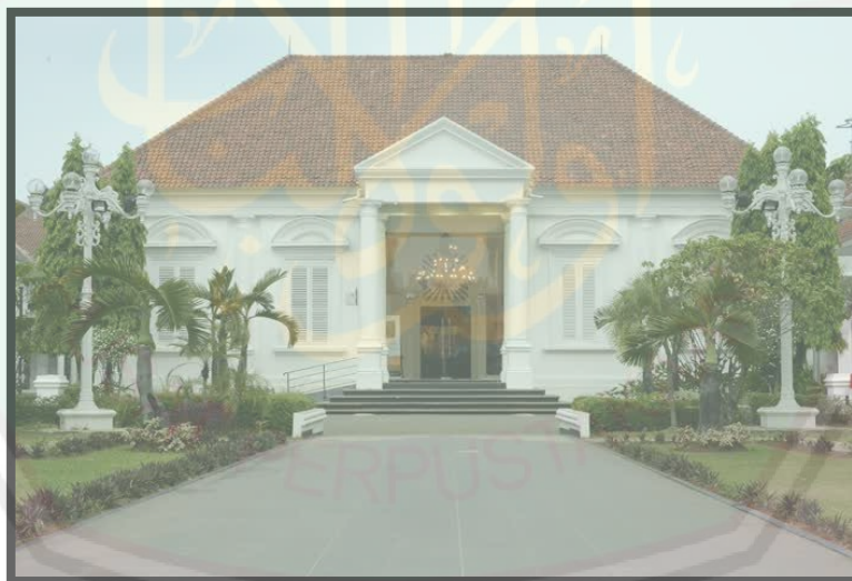
Gambar 2.41 Tampak Depan Gedung A Sumber: http://galeri-nasional.or.id/ , 2015)
