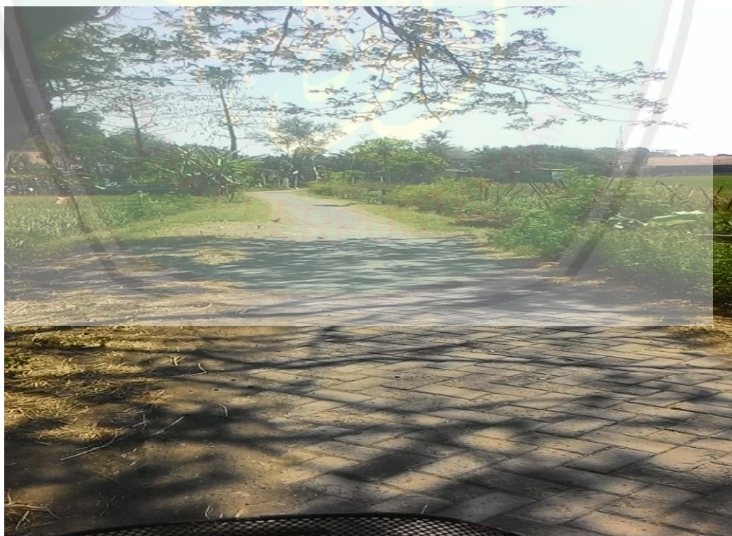
Hasil Perbaikan Jalan (Pavingisasi)
