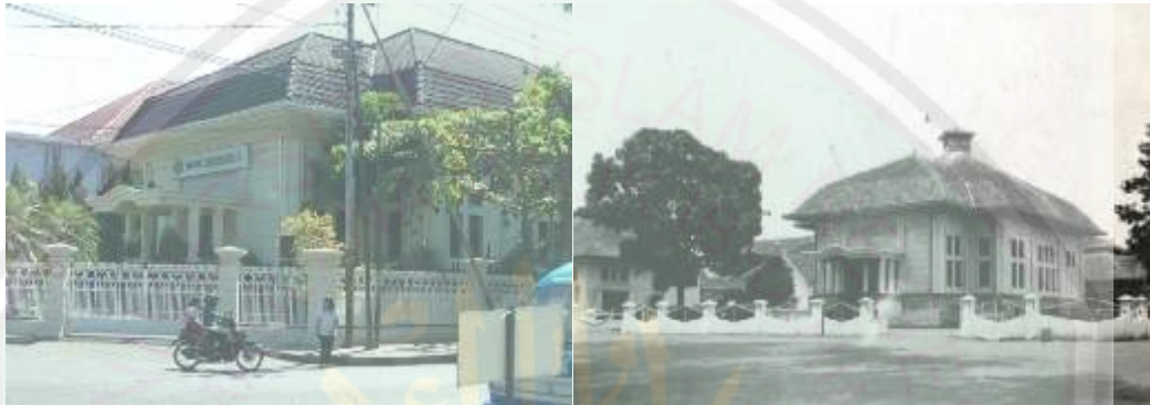
Gambar 2.10 dan 2.11 Gedung Bank Indonesia Malang Sumber : Google.co.id
