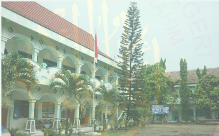
Dokumentasi Gedung SMA Nurul Jadid Putra I
