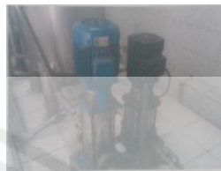
Gambar 2.6 Pompa Grundfos CR8-50
