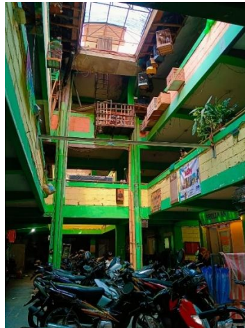
Gambar 4. 2 Bangunan Rumah Susun A
