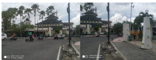
Gambar 4.19 Jalan Tanpa Jembatan 149
