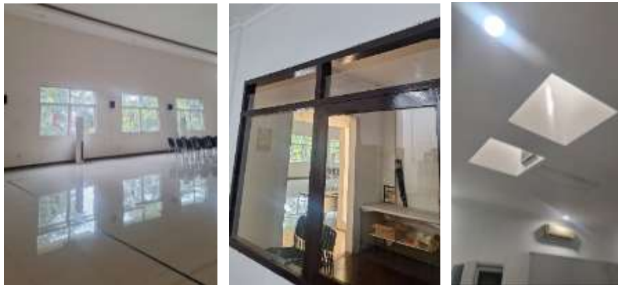
Gambar 4.7: Gambar Pertama Cahaya Masuk Dari Jendela Ruang Aula Utama, Gambar Kedua Cahaya Dari Ruang Aula Masuk Kedalam Ruang Arsip Melalui Jendela, Gambar Ketiga Pencahayaan Alami Dari Celah Exhaust Fan Di Ruang Arsip Kantor Kementerian Agama Kota Malang.
