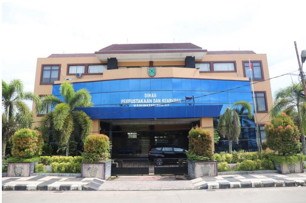
Gambar 4.1.1 Gedung Dinas Perpustakaan dan Kearsipan Kabupaten Berau
