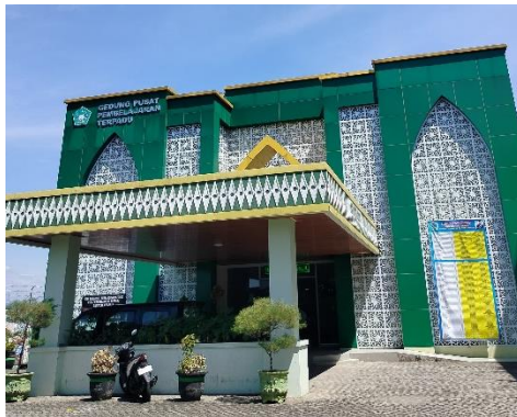
Gedung SBSN MAN 2 Nganjuk
