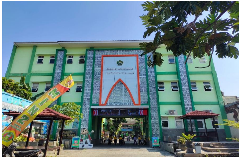
Gedung SBSN 2023 (digunakan untuk kelas 6)
