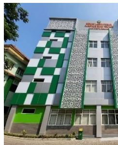
Gambar 3 : Gedung Laboratorium Olimpiade
