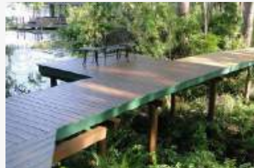
untuk kawasan Boardwalk menggunakan papan kayu yang dilapisi anti pelicin , agar saat musim hujan tidak lembab
