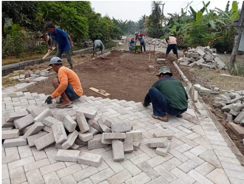
Lampiran 5. Dokumentasi pelaksanaan program PPM Perbaikan Jalan di dusun Ringinagung (Kepala Dusun Ringinagung, 2025)
