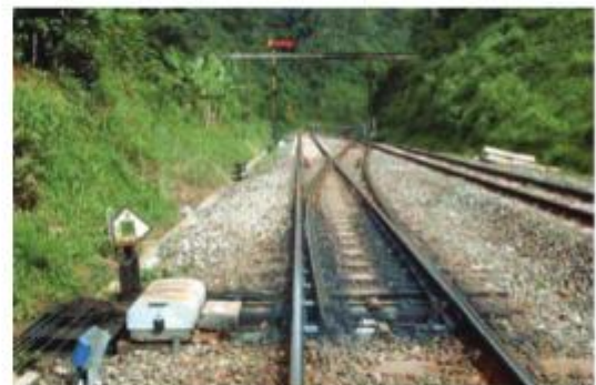
Gambar 2.43: Motor penggerak wessel [26]
