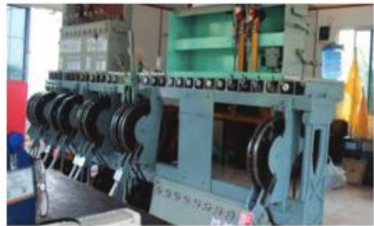
Gambar 2.42: Meja pengendali sinyal mekanik [26]
