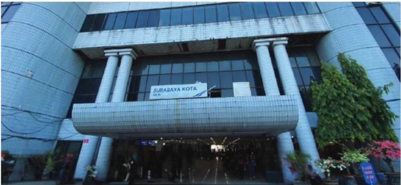
Gambar 1.15 : Foto Tampak Depan
