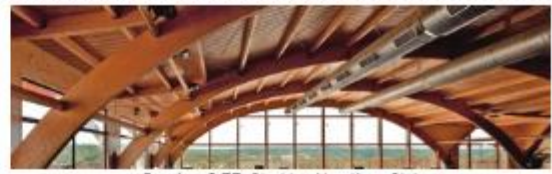
Gambar 2.33: Struktur Atap Kayu Glulam
