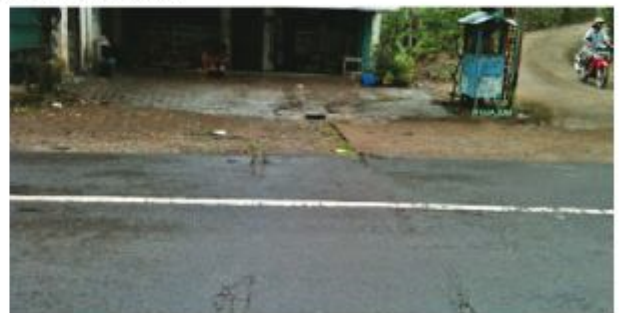
Gambar 1.6 : Perpotongan rel kereta dengan jalan raya Slahung [12]
