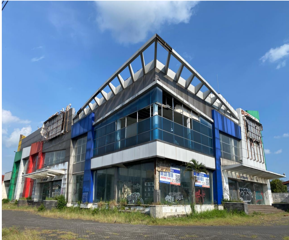
Gambar 1. Kondisi Bangunan Mall Dhoho Square Kota Kediri
