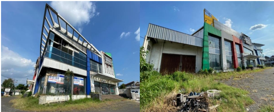
Gambar 2. Kondisi sisi samping Bangunan Mall Dhoho Square Kota Kediri
