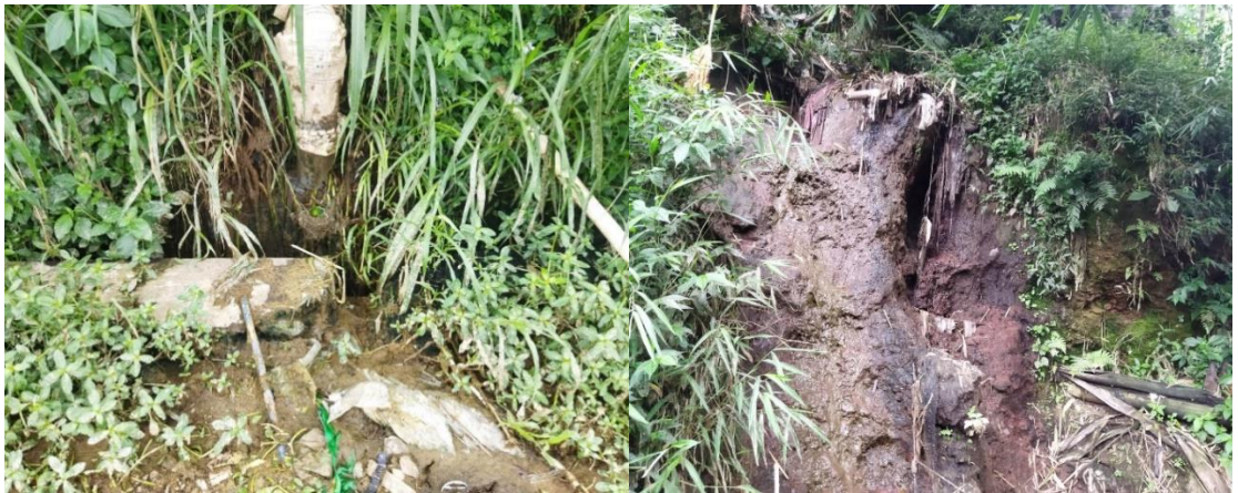
Foto 3.3, pembuangan limbah kotoran yang dialirkan lewat pipa menuju selokan. (21/01/2026)
