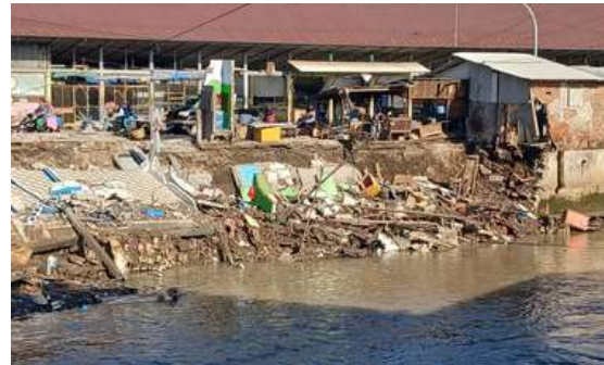
Gambar 4: Kondisi Bangunan yang ambruk ke sungai [7]
