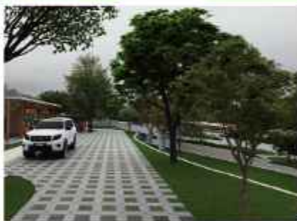
Perkerasan yang bisa dibongkar menggunakan paving green
