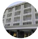
Penambahan secondary skin pada sisi barat dan timur untuk menghalang silau matahari yang masuk.
