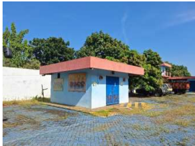
Gambar 6. Gudang E : Penyimpanan Zat Berbahaya
