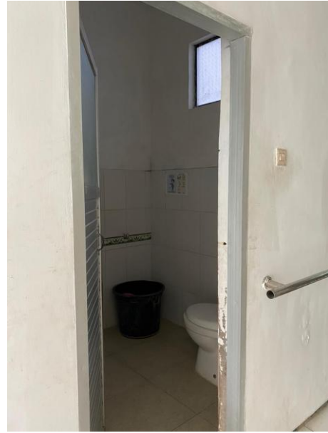
Gambar 13. Kamar Mandi SLB ABD Negeri Kedungkandang Malang
