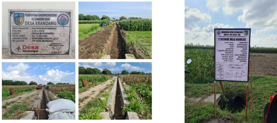
Gambar 11. Proyek Perbaikan Irigasi Sawah
