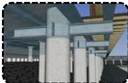
Pondasi Tiang Pancang
