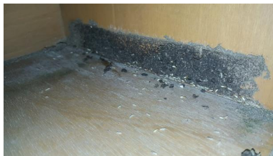
Gambar 4. 4 Kondisi rak yang terserang rayap (Sumber: Dokumentasi pustakawan, 2021)
