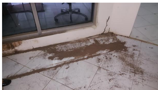
Gambar 4. 5 Kondisi lantai yang terserang rayap (Sumber: Dokumentasi pustakawan, 2021)
