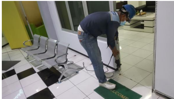
Gambar 4. 10 Proses suntik rayap setiap satu meter (Sumber: Dokumentasi pustakawan, 2021)
