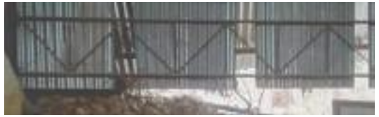
Scaffolding penyangga Bracing scaffolding Nepal. Sebagai penguat gaya horizontal gempa
