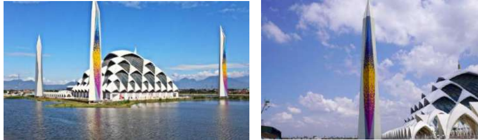
Gambar 2.6 Bangunan Masjid Al-Jabbar
