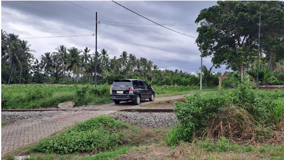
Gambar 1 Perlintasan Sebidang Resmi Tidak Ada Palang Perlintasan Ketika Dilalui Oleh Mobil Roda 4
