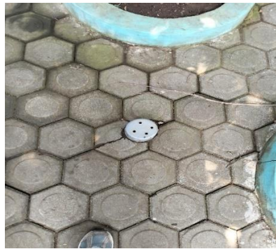
Gambar 4.14 Ketersediaan Biopori di MAN Lumajang. 85
