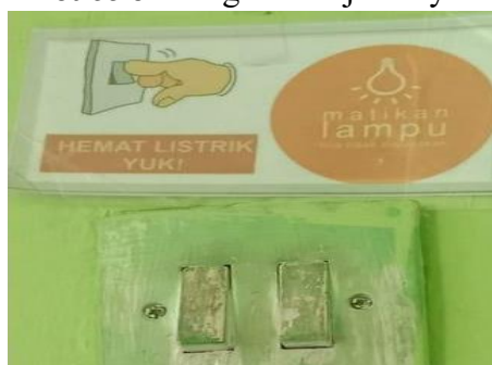
Gambar 4.16 Pemasangan Notice Hemat Energi. 149
