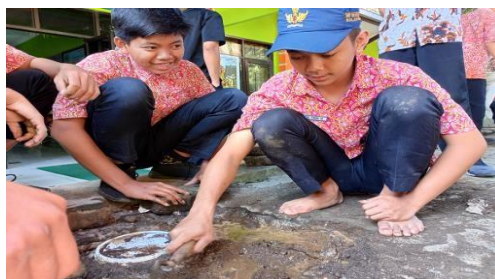
Gambar 4.38 Program Drainase berupa pembuatan biopori. 180
