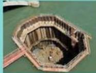
Cofferdam dan caisson adalah struktur kedap air yang digunakan untuk membangun sesuatu di dalam air, seperti pondasi jembatan, tiang pancang, atau bangunan pelabuhan. Cofferdam bersifat sementara, sedangkan caisson bisa permanen. Banyak cofferdam dan caisson berbentuk prisma segi empat, segi enam atau segi delapan, karena bentuk ini stabil dan mudah dibangun
