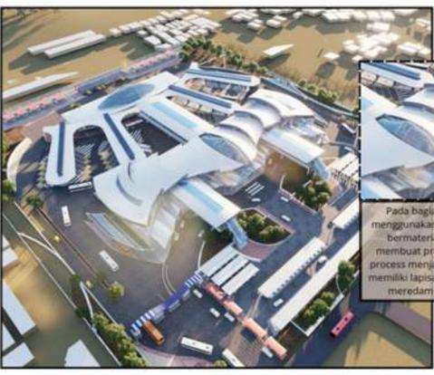
Pada bagian atap bangunan menggunakan atap lengkung yang bermaterial PTFE membran membuat prinsip celebration off process menjadi terasa, material ini memiliki lapisan anti UV yang dapat meredam panas bangunan
