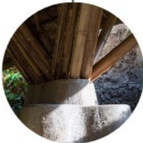
kolom bambu disambungkan dengan pondasi yang terbuat dari beton agar terhindar dari kelembapan tanah
