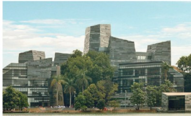
Fasad Perpustakaan Universitas Indonesia
