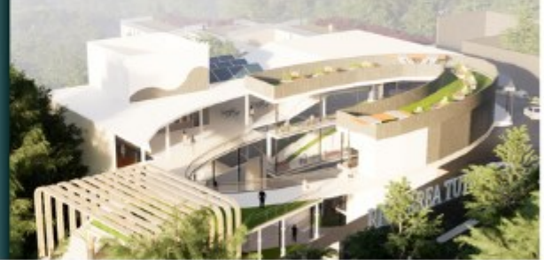
Jalur pemisah antara jalan dan ruangan. Di fungsikan sebagai tempat duduk dan toilet untuk tamu dan sopir
