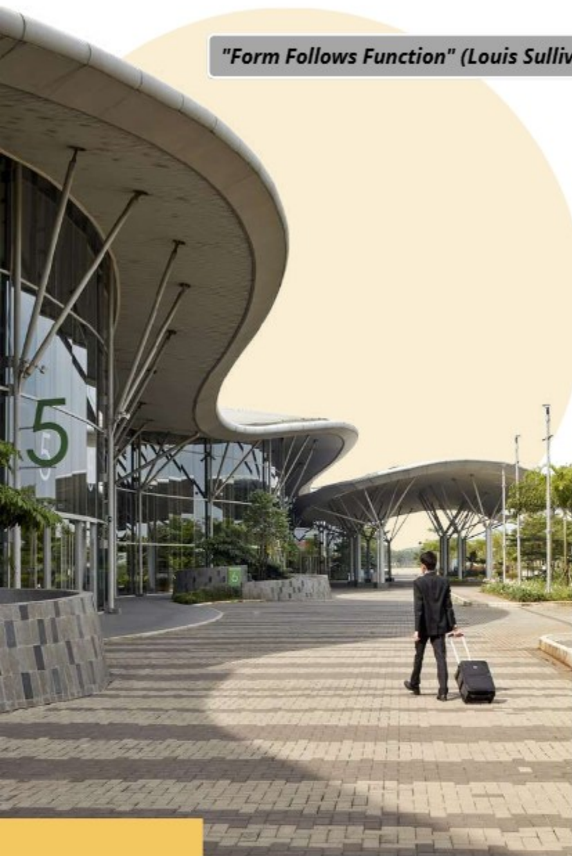
Gambar 1.17 Teknologi Fasad Bangunan ICE BSD
