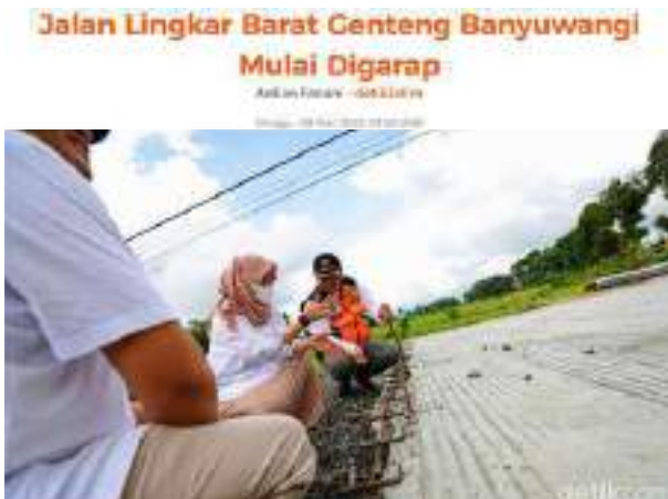
Gambar 3 : Bupati Banyuwangi meninjau betonisasi jalan lingkar barat di Genteng Sumber : https://www.detik.com/jatim/berita/d-6391207/jalan-lingkar-barat-genteng-banyuwangi-mulai-digarap
