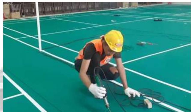
Pemasangan Lapangan Badminton Sumber : Raga Sport
