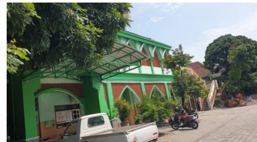
Bangunan MAN 1 Kota Kediri
