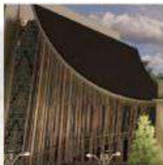
Secondary skin berbahan kayu pada bagian fasad
