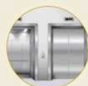
Lift sebagai prasarana akses
