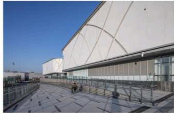
Gambar 19. Area ramp pada enterance
