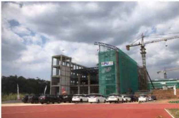
Gambar 13. Pembangunan asrama atlet
