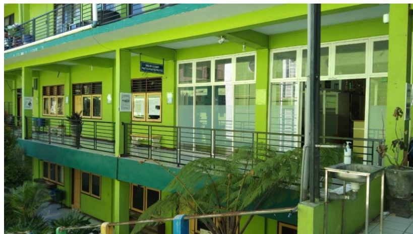
Gedung SMK Unggulan An-Nur
