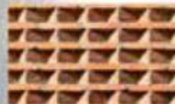
MATERIAL PADA KESELURUHAN FASAD BANGUNAN
