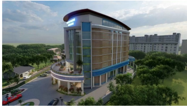
Gambar 4.2: Gedung kampus 2 dan 3 Universitas Muhammadiyah Gresik 116
