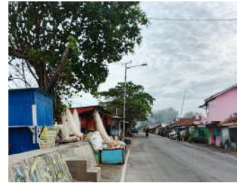
Permukiman yang terlalu dekat dengan garis pantai
