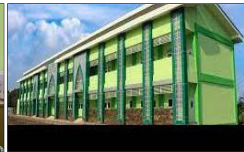
Tampak depan gedung putra
