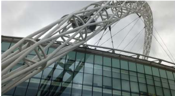
Gambar 2.40 Struktur Lengkung Wembley Stadium Sumber : pinterest
