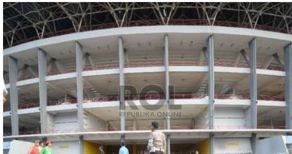
Gambar 2.55 Fasad Stadion Utama Gelora Bung Karno
