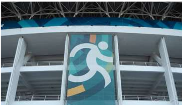
Gambar 2.53 Fasad Stadion Utama Gelora Bung Karno
