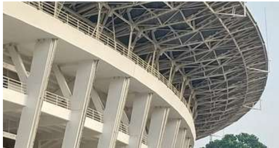
Gambar 2.54 Material Struktur Stadion Utama Gelora Bung Karno
