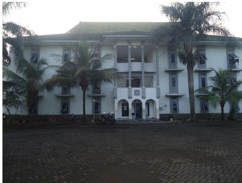
Gambar 4.2 Tampak Depan Salah Satu Bangunan Ma'had
